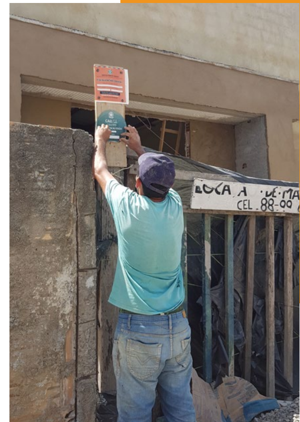
Figura 12: Adesivo da fiscalização do CAU/CE afixado no local da obra. Fonte: Acervo CAU/CE 2022.
